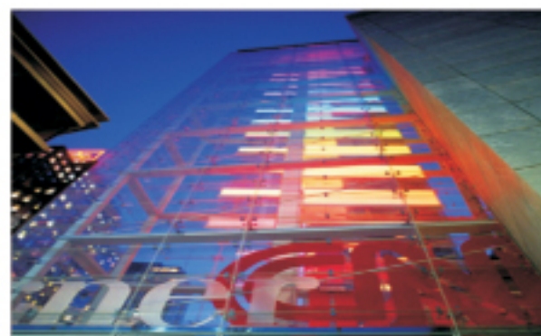
Obr. 6. Osvětlení budovy Time Warner Center v New Yorku
