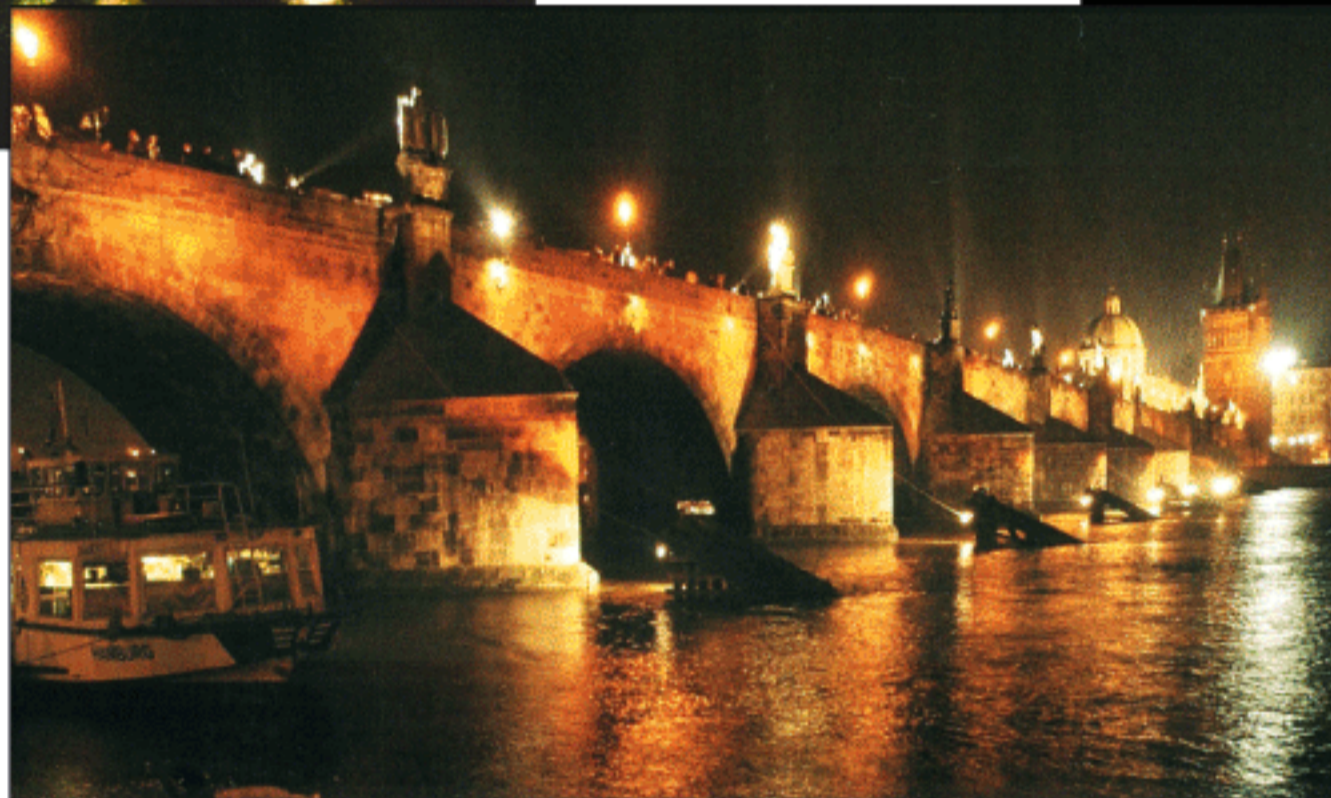
Obr. 2. Osvětlení Karlova mostu
